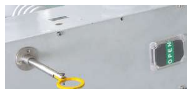
Vástago de operación (posición abierto)
